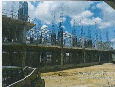
ARMADO DE ACERO COLUMNAS Y PANTALLA NIVEL + 11,80 BLOQUE 1 - 03/10/2023
