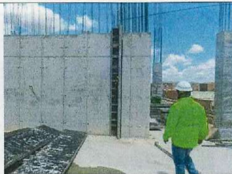
ARMADO DE ESCALERA FORMALETA NIVEL 0,00 AL 4,20 BLOQUE 1 - 10/10/2023
