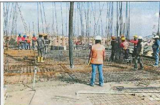
ARMADO DE ACERO PLACA CONTRAPISO BLOQUE 7 - 26/10/2023
