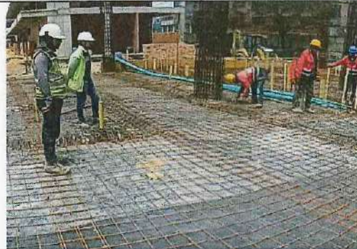
ARMADO DE ACERO COLUMNAS Y PANTALLAS NIVEL + 8,00 BLOQUE 2 - 27/10/2023
