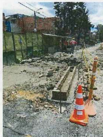
Construcción de cárcamo en entrada 2. Fecha: 10-10-2023.
