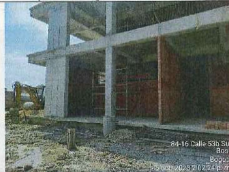
ARMADO DE ESTRUCTURA STEN NIVEL + 8,00 BLOQUE 2 - 06/10/2023
