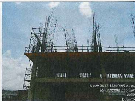
FUNDIDA COLUMNAS NIVEL + 8,00 BLOQUE 1 - 05/10/2023
