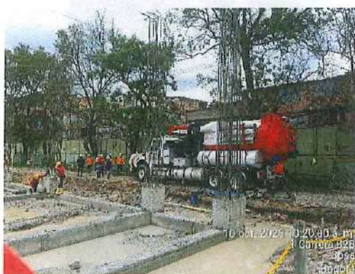
Limpieza de pozo séptico y caja de inspección. Fecha: 10-10-2023.
