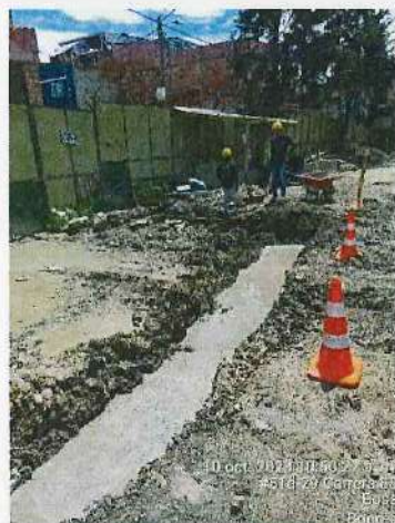
Construcción de cárcamo en entrada 2. Fecha: 10-10-2023.
